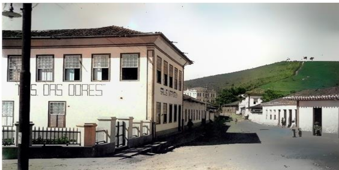
PRÉDIO ORIGINAL DO HOSPITAL NOSSA SENHORA DAS DORES.
